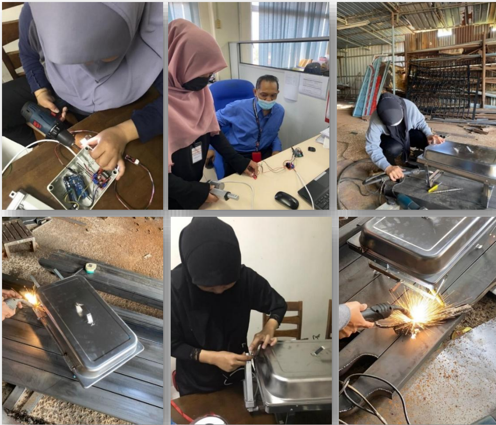
Rajah 3 Kerja-kerja pemasangan yang dilakukan
