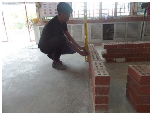
2) Kepugakkan Tembok Tembok
